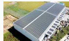
自家消費／武智発電所 容量：417.45kW
